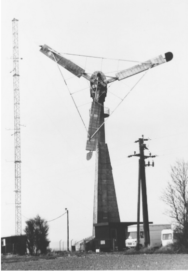
a) Gedser wind turbine (200 kW, D = 24 m, DK 1957)
