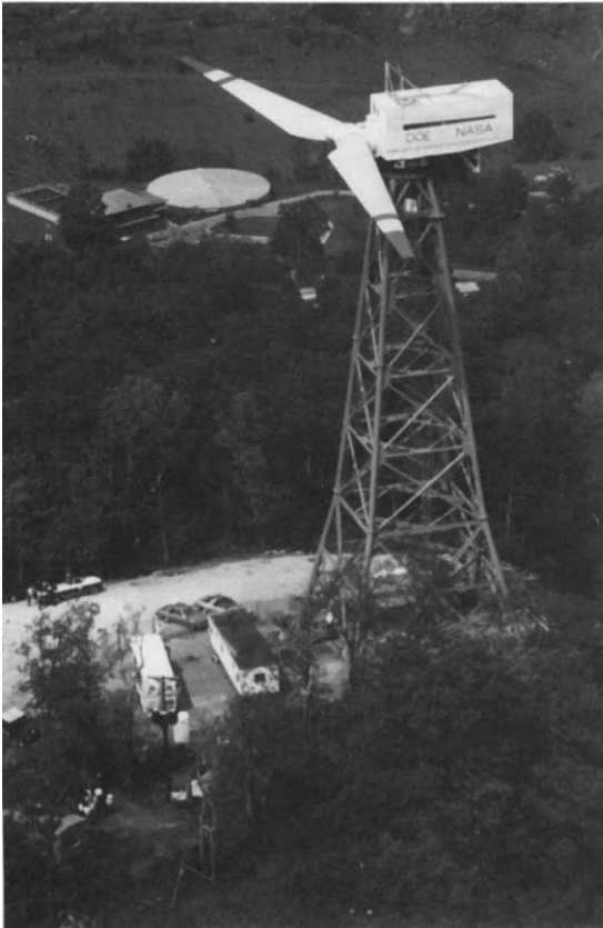
17. MOD.1 wind turbine (USA).
