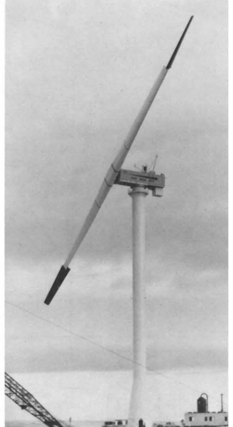
18. MOD.2 wind turbine (USA).
