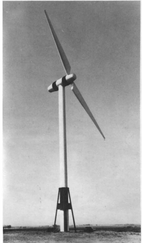
26. Maglarp wind generator (Sweden).
